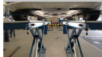
4 csöves világítás a rámpákba építve
